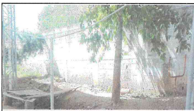
REPARACIÓN DE MURO PERIMETRAL DE BLOCK CON TUBO HG Y MALLA GALVANIZADA, SOLERA INTERMEDIA Y COLUMNAS
