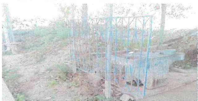
SUSTITUCIÓN DE PILA
