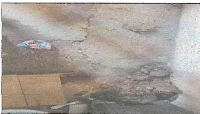
SUSTITUCIÓN DE PISO DE TORTA DE CONCRETO
