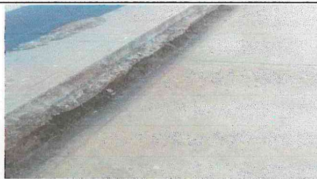
REPARACIÓN DE BANQUETA DE CONCRETO
