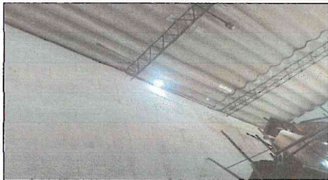
SUSTITUCIÓN DE LÁMINA POR LÁMINA TROQUELADA
