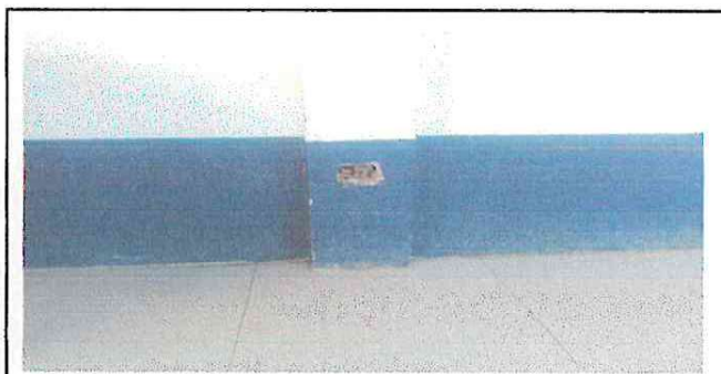
SUSTITUCIÓN DE TOMACORRIENTES DOBLES
